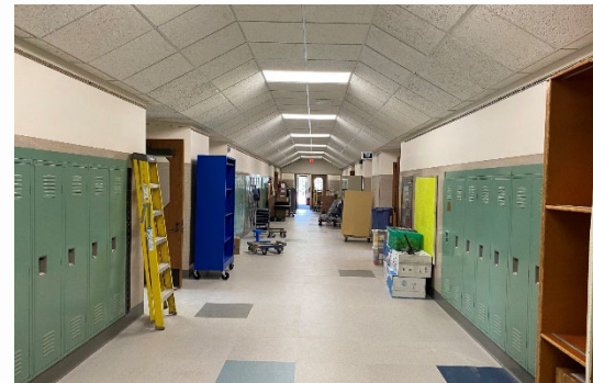
Maire ES New Ceilings and Lighting
