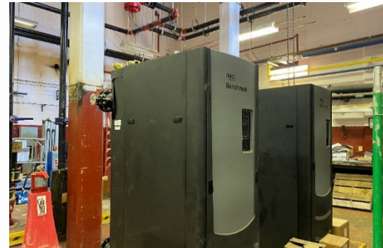
Maire ES New Hydronic Condensing Boilers
